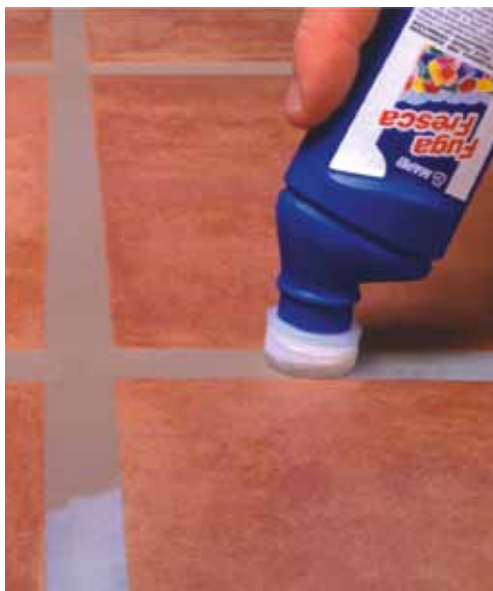
Traitement de joints de sol en terre cuite avec Fuga Fresca.
